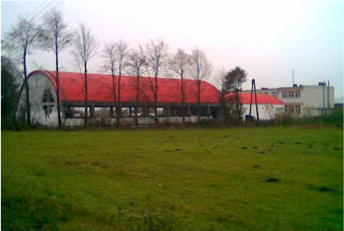
Na zdjęciu – budowana sala gimnastyczna przy Zespole Szkół Gminnych w Prostyni.
