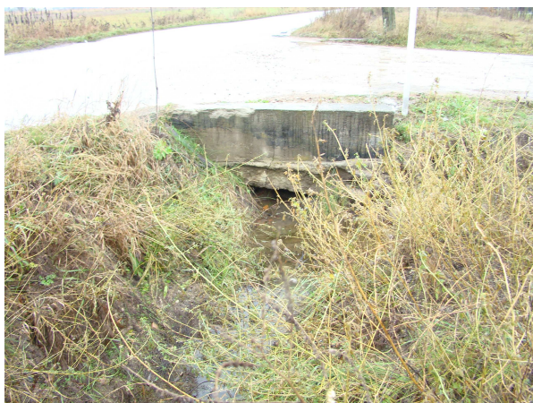
wlot i ścianka wlotowa przepustu wzdłuż drogi powiatowej
