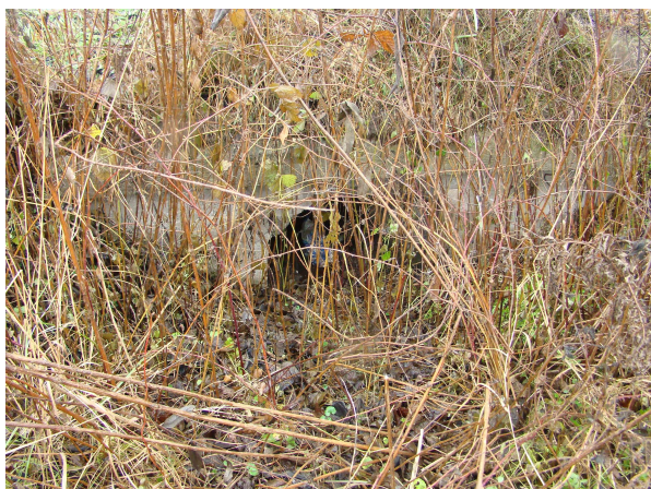
wlot i część przelotowa przepustu pod drogą powiatową
