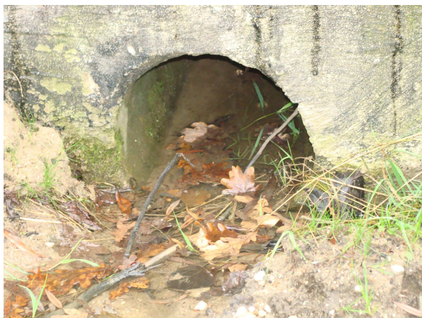
część przelotowa i rejon wylotu przepustu pod projektowaną ulicą
