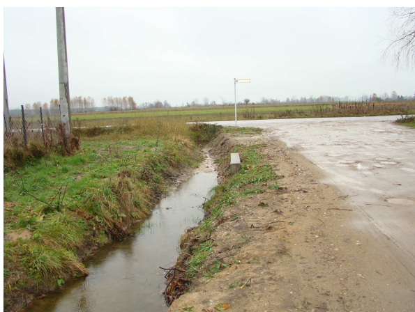
rów doprowadzający i wlot przepustu – ścianka przepustu do rozbiórki
