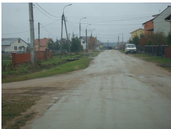
początek istniejącego rowu lewostronnego
