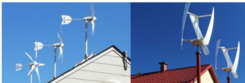
Rysunek 8. Przykłady małych turbin wiatrowych. Po prawej z poziomą osią obrotu, po lewej z pionową osią obrotu
