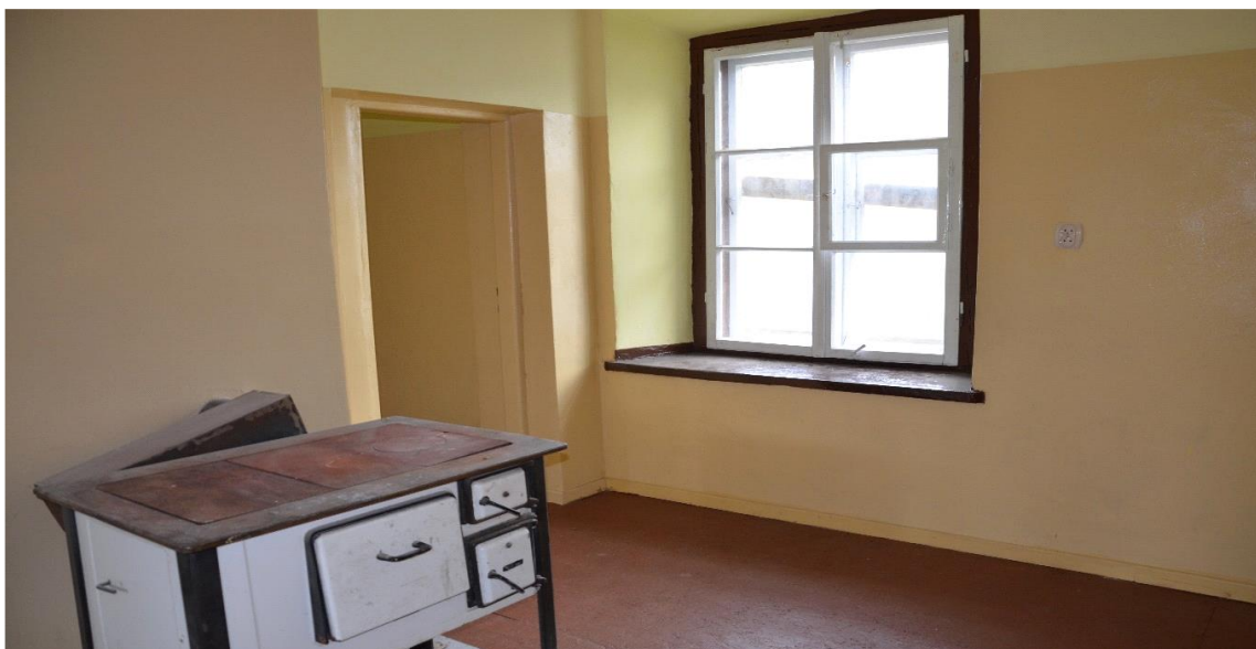
Wyremontowany lokal komunalny przy ul. Biegańskiego 5
