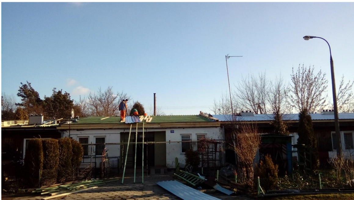
Remont pokrycia dachowego przy ul. Leśnej 20
