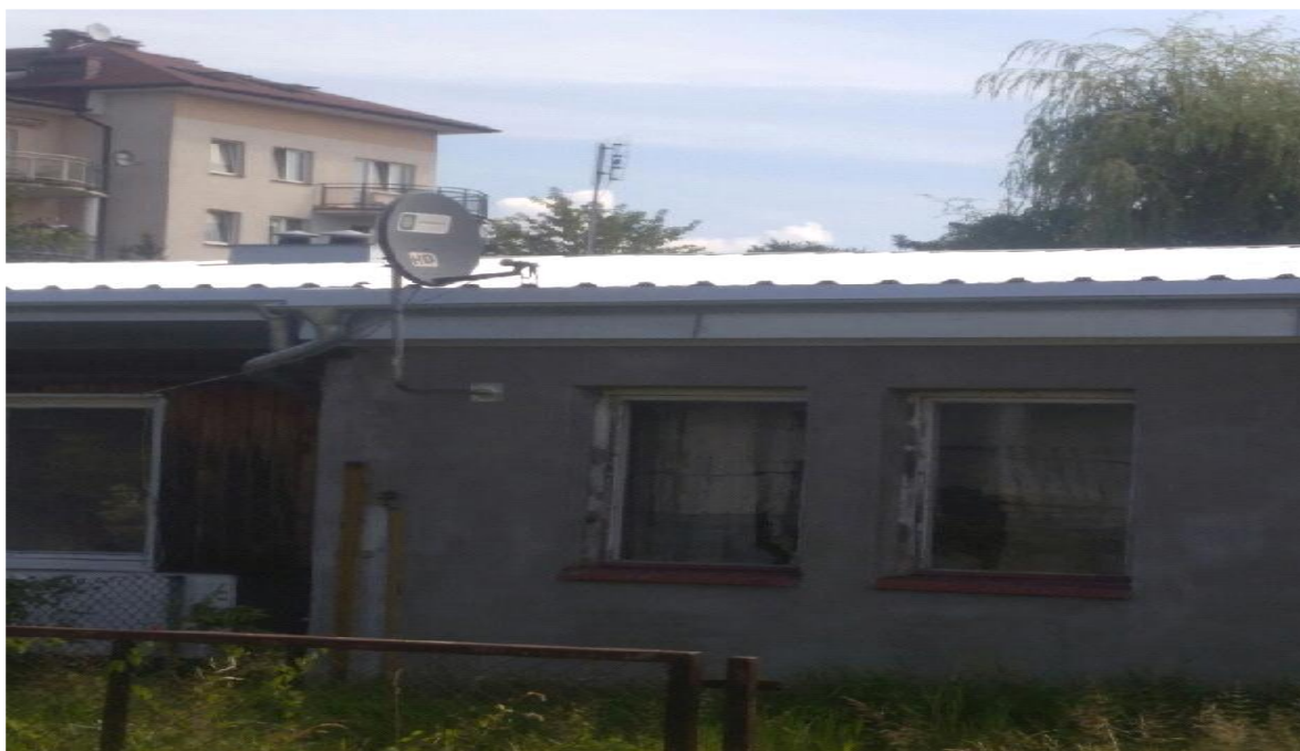
Remont pokrycia dachowego przy ul. Leśnej 18
