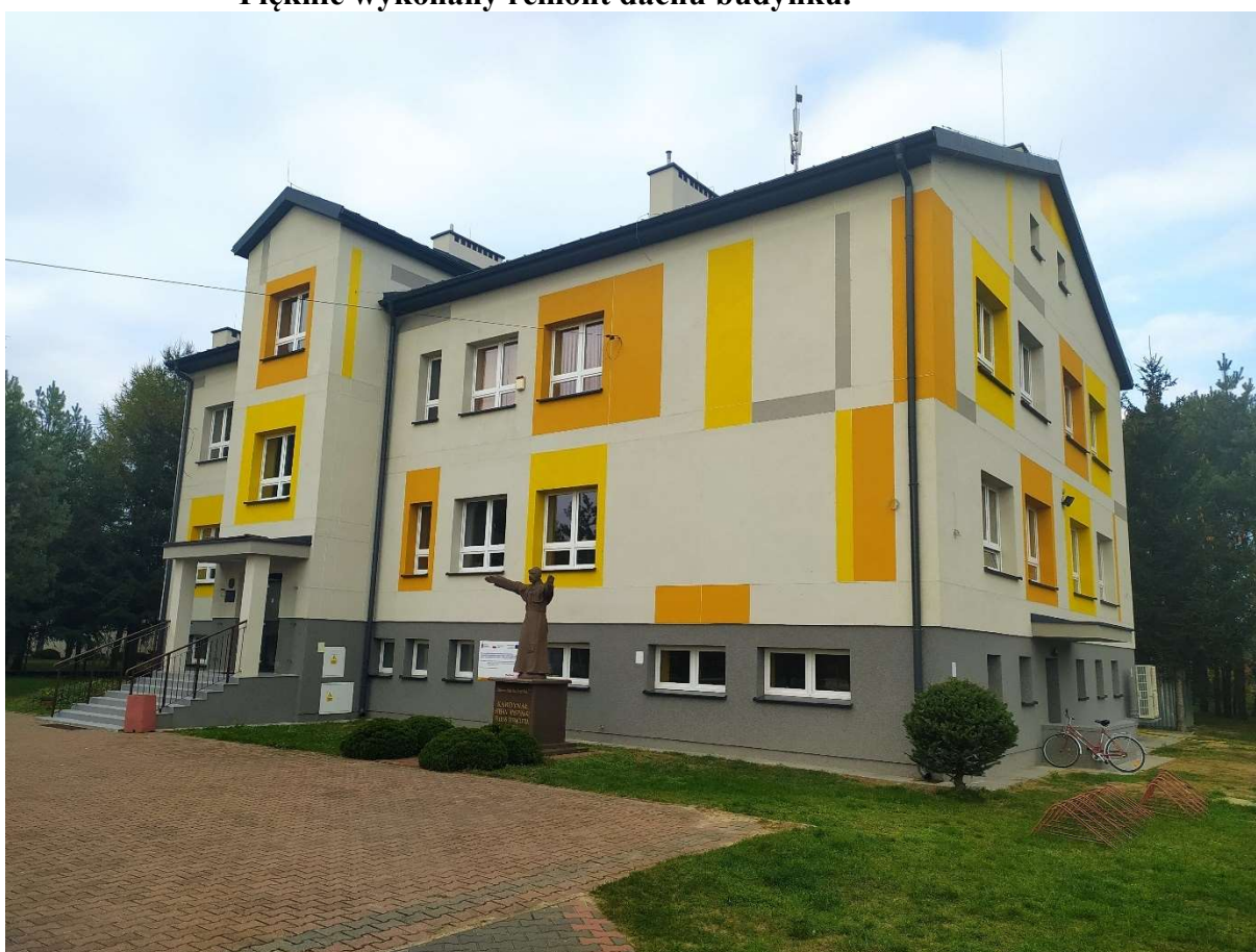
Szkoła Podstawowa im. Kard. Stefana Wyszyńskiego w Kielczewie po wykonaniu termomodernizacji.
