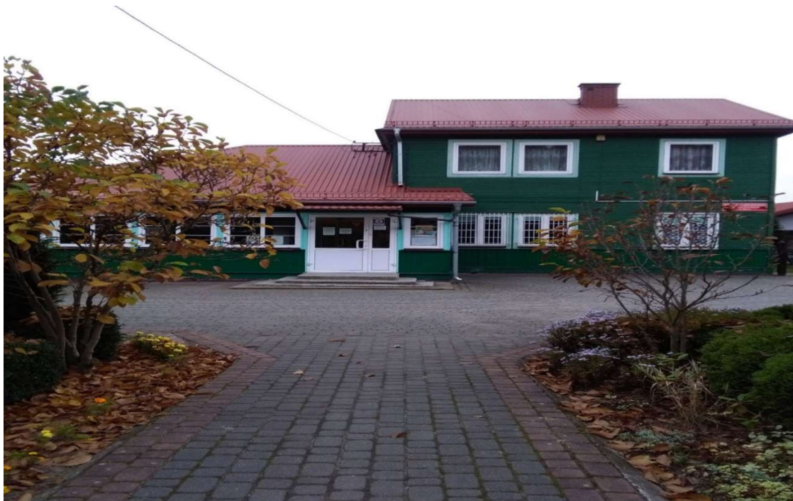
Szkoła Podstawowa im. ks. Jana Twardowskiego w Glinie Pięknie wykonany remont dachu budynku.
